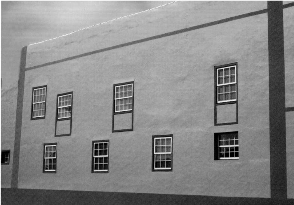
Fachada lateral de la casa Anchieta
